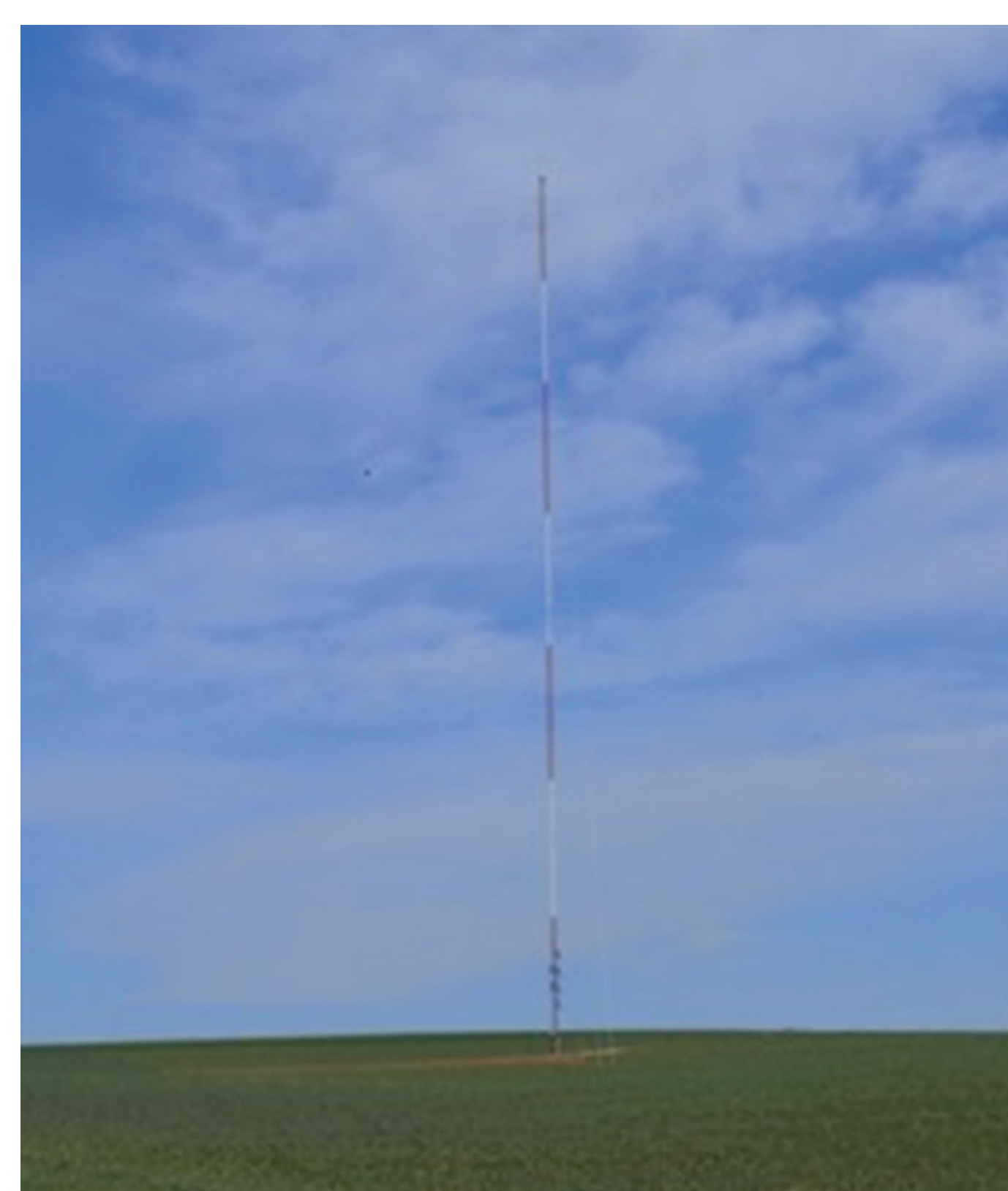
Photo d'un mât de mesure
